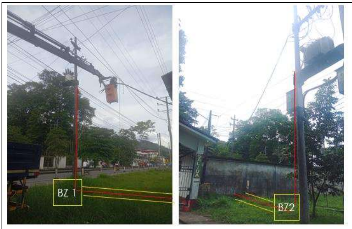
Instalación de BZ MT 01 y BZ MT 02, Zanja, cable de energía tipo N2XSY
