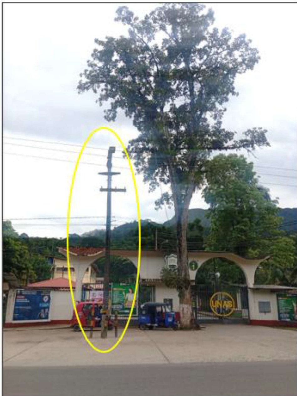
RETIRO DE POSTE DE CONCRETO DE MT UBICADO FRENTE A LA PUERTA 01 DE LA UNAS
