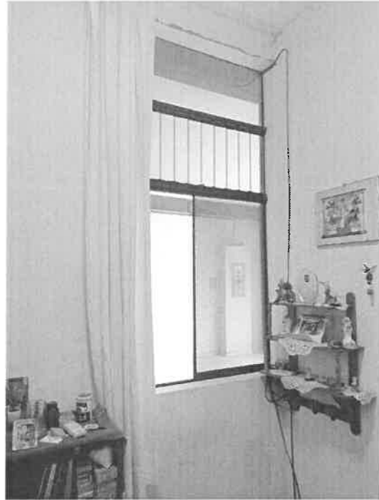
Figura N° 01: INSTALACION DE REJAS DE PROTECCION PARA VENTANA 01 (1.10X2.10M)
