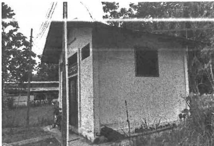
Con presencia de la cobertura inadecuada, de techo de calamina, que no garantizan la vida útil de la UP.
