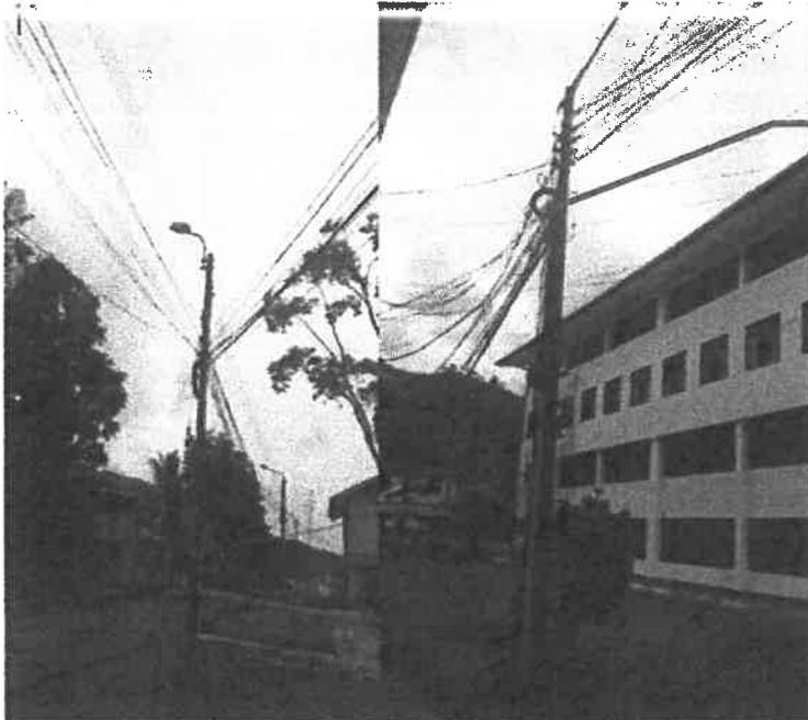
En estas condiciones, este nuestro sistema eléctrico en cuanto a lo que se refiere los tendidos de media tensión, sin cumplir ninguna especificación técnica de calidad de servicios y las otras empresas de que proveen servicios de TICs, instalan sus cables, en los postes que sirven para la luz eléctrica, sin respecta la normatividad vigente en y pueden ocurrir riesgos eléctricos y afectar a la salud de las personas que trabajan en la institución.
